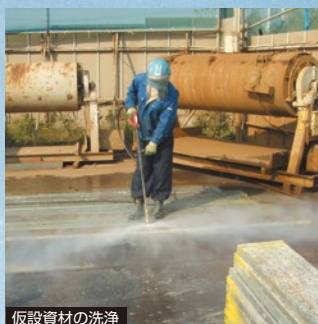
仮設資材の洗浄
