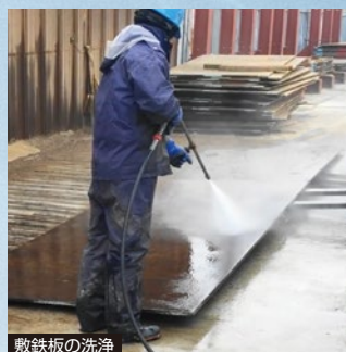
敷鉄板の洗浄
