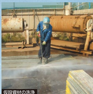
仮設資材の洗浄
